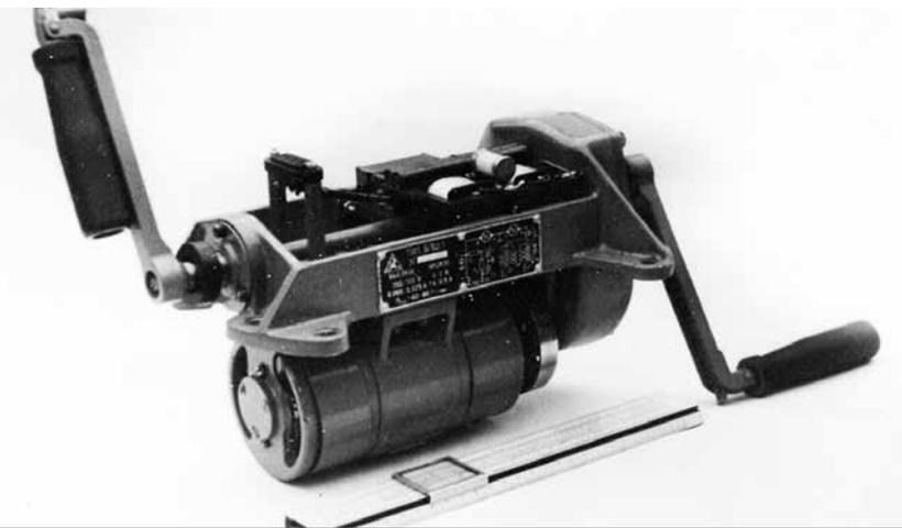
*Первая разработка предприятия — блок регулируемых генераторов с ручным приводом для питания шлюпочной аварийной радиостанции (фото 1956 г.)*
