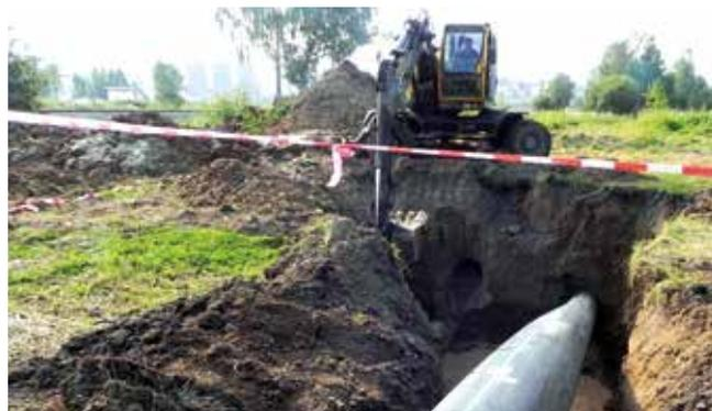
Прокладка линии методом горизонтального направленного бурения между двумя канализационными насосными станциями № 5 и № 13, август 2013 г.
