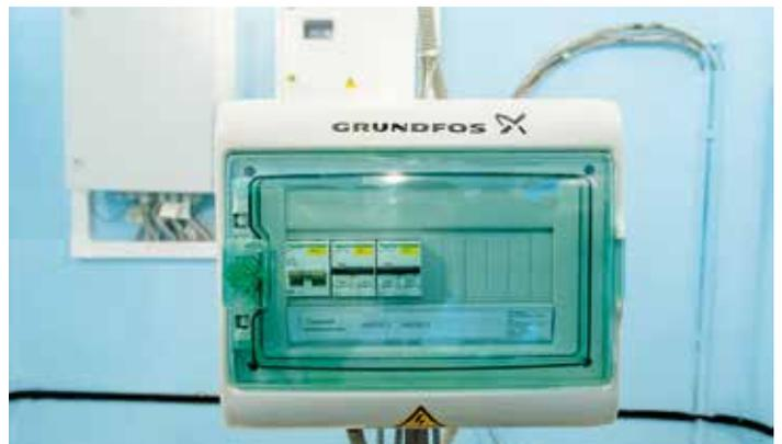
ВНС по ул. Кулагина после модернизации: пульт управления насосными агрегатами
