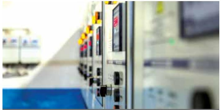
КНС по ул. Сибирской, работающая в автономном режиме: шкафы управления магистральными и напорными задвижками
