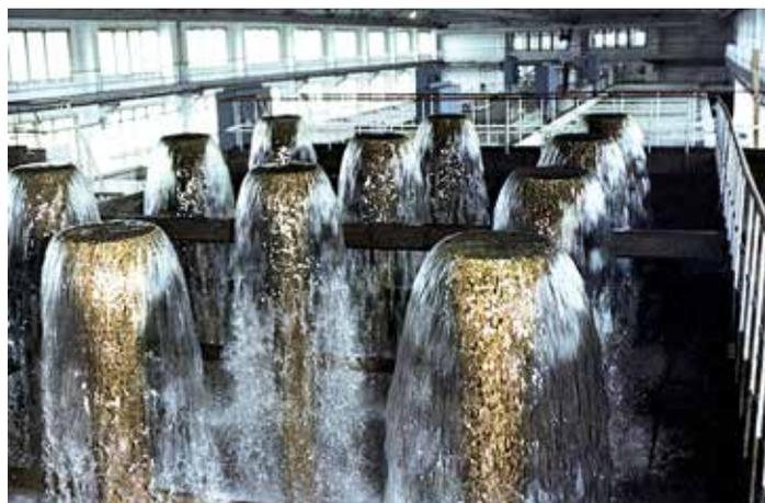
Аэраторы станции обезжелезивания водозабора из подземных источников
