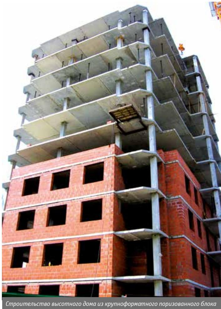
Строительство высотного дома из крупноформатного поризованного блока
