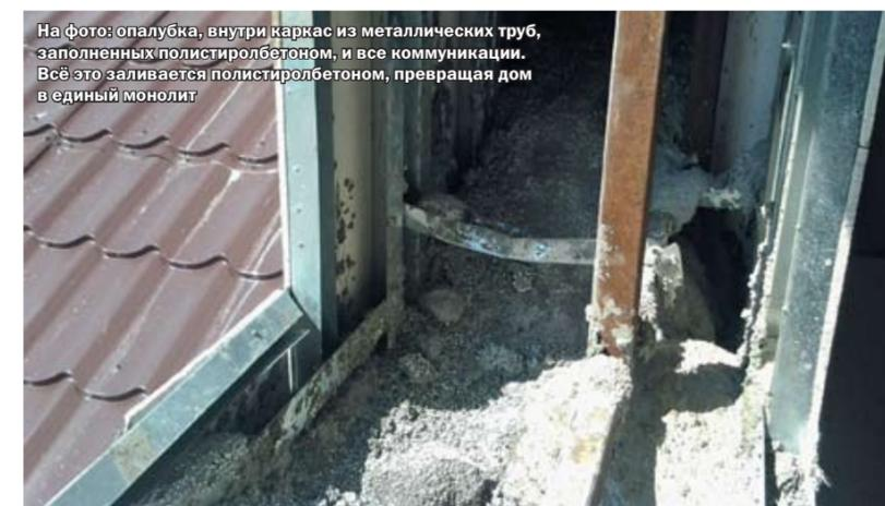
На фото: опалубка, внутри каркас из металлических труб, заполненный полистиролбетоном, и все коммуникации. Всё это заливается полистиролбетоном, превращая дом в единый монолит
