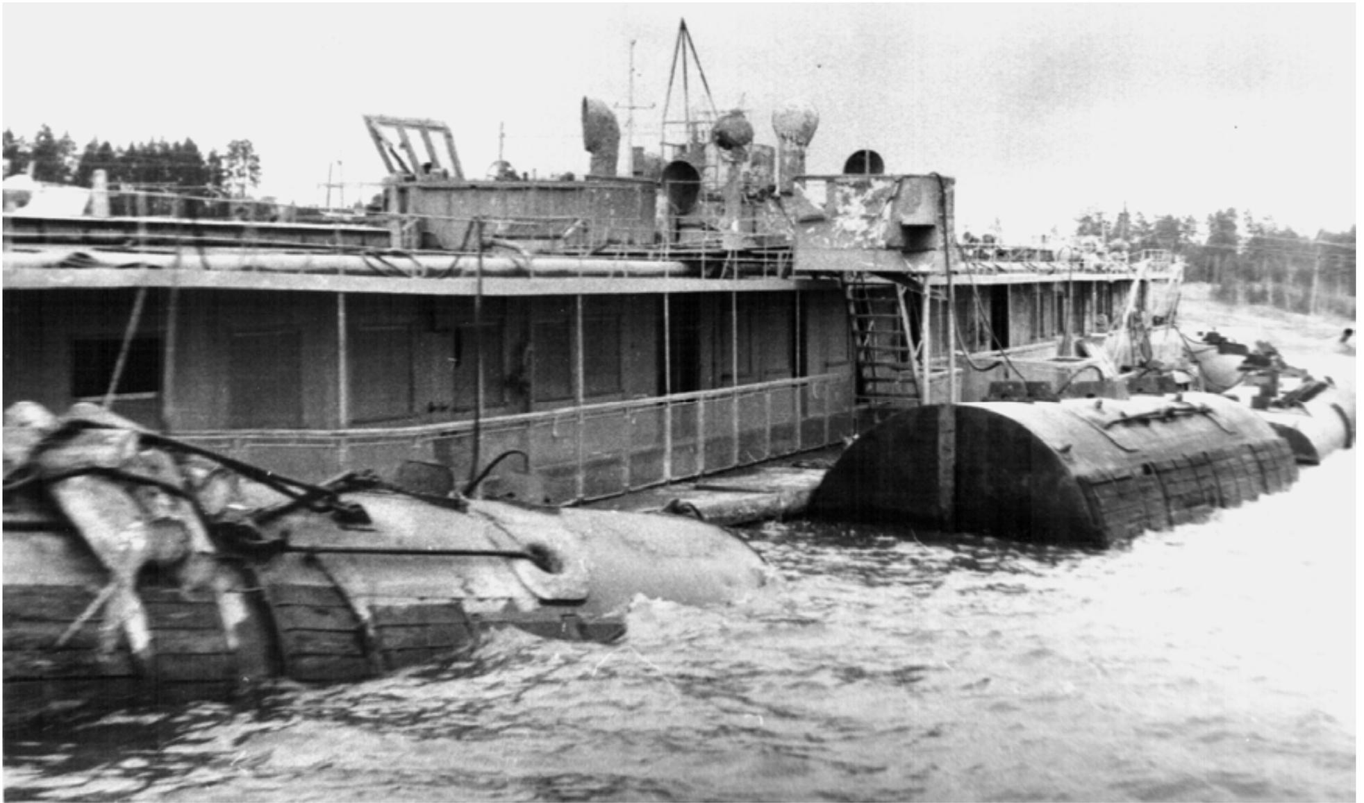
1967 год. Подъем затонувшего парохода понтонами. Осадка системы «пonton – пароход» составила более 3-х метров. Было принято решение: вытащить его на берег тягачами.
