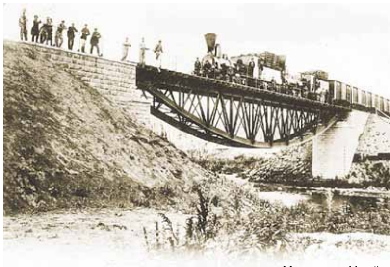
Мост через Ушайку
