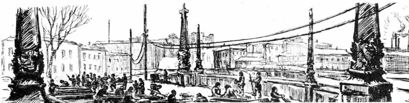
Строительство городской железной дороги в Томске в районе Каменного моста. Иллюстрированное приложение к газете «Красное знамя», ноябрь 1941 г.
